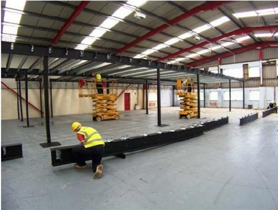
Sökülüp takılabilir ara kat inşası
